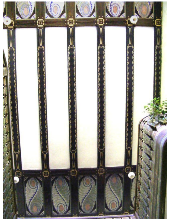
Blick im Treppenhaus gegen die Decke
